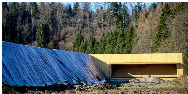
La zona bersagli del nuovo poligono dinamico con bunker di trocioli di legno sul bordo superiore del muro di protezione di nuova costruzione.
