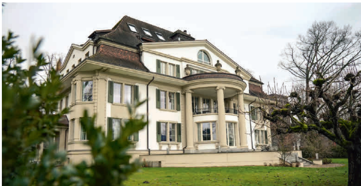
Frontansicht vom Haus der Schützen in Luzern, in dem sich die Geschäftsstelle des SSV befindet.
