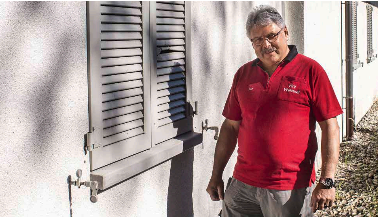
Hier sind die Einbrecher eingestiegen: Vereinspräsident Dieter Rothacher vor dem lädierten Fensterladen an der Seitenwand des Schützenhauses.
