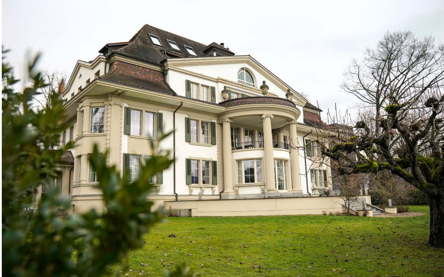
Frontansicht vom Haus der Schützen in Luzern, in dem sich die Geschäftsstelle des SSV befindet.
