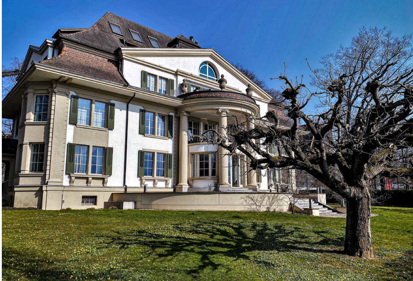
Frontansicht vom Haus der Schützen in Luzern, in dem sich die Geschäftsstelle des SSV befindet.
