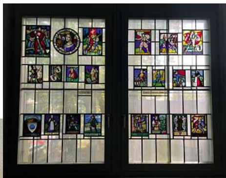
Alte Elemente sollen erhalten bleiben und in die Zukunft mitgenommen werden.
