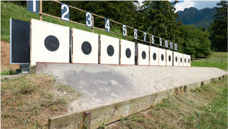
Abb. 40: Vorkugelfang Sand mit montierter Prellplatte
