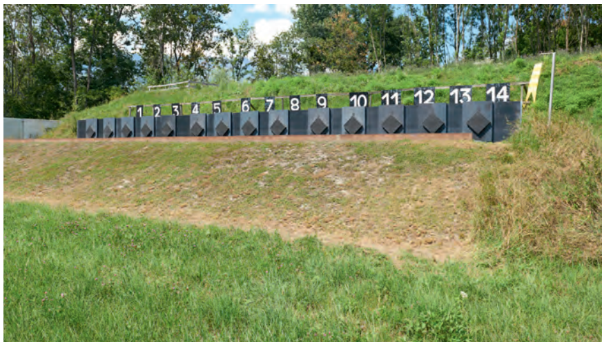
Abb. 39: Vorkugelfang Erde mit montierter Prellplatte
