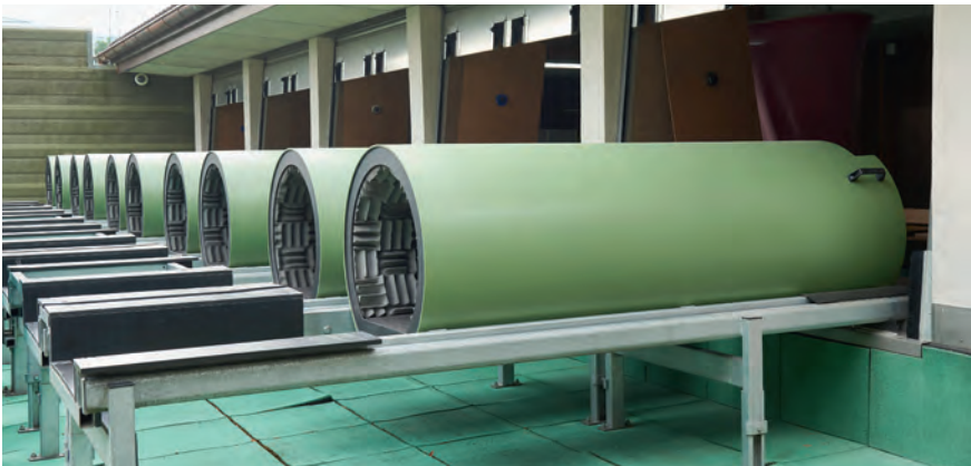
Abb. 22: Schallschutztunnel (rund)
