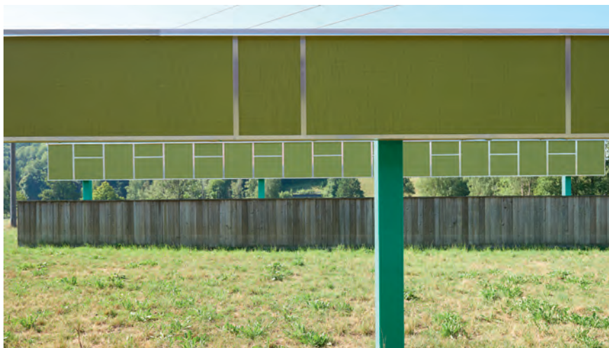
Abb. 62: Betontiefblende und 2 Hochblenden Nahblendenkonstruktion
