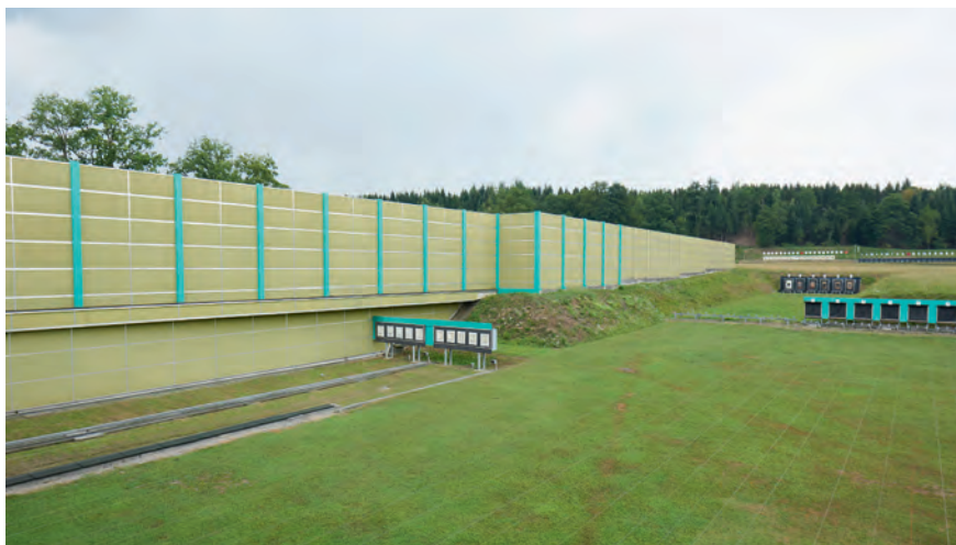
Abb. 21: Schallschutzwand aussen nicht begrenzt
