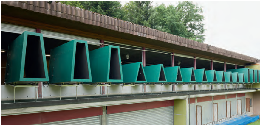
Abb. 23: Schallschutztunnel (dreieckig)
