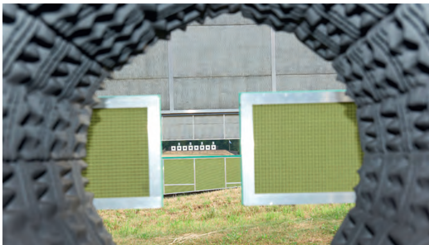
Abb. 63: Seitenblende Nahblendenkonstruktion mit Tunnel (Sicht des Schützen)
