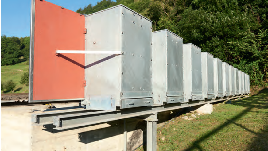
Abb. 48: Kugelfangsystem Seitenansicht L+H
