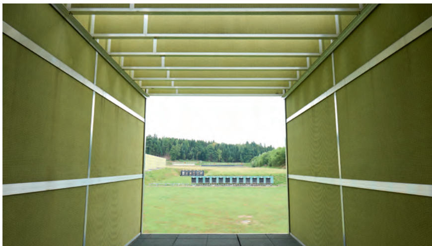
Abb. 20: Schallschutzwand mit Fächer oben
