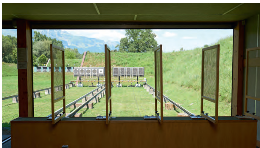
Fig. 66: Stand di tiro alla pistola con banco di caricamento e pareti divisorie
