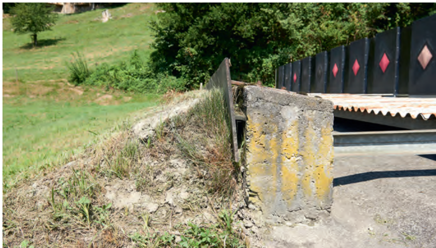
Fig. 38: Veduta della piastra d'acciaio montata
