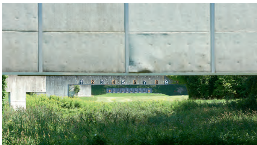
Fig. 57: Paratia laterale e d'altezza in cemento armato
