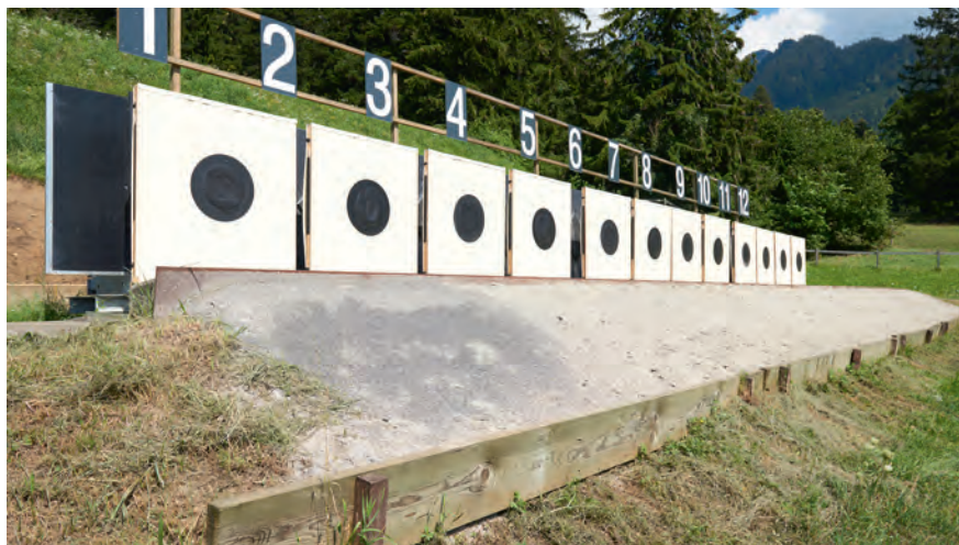
Fig. 40: Pre-parapalle in sabbia con piastra d'acciaio montata
