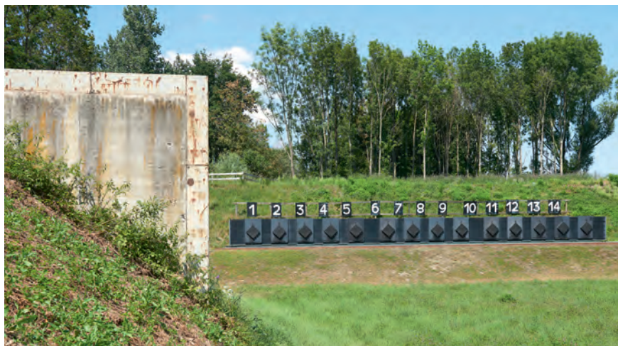
Fig. 58: Paratia laterale in cemento armato
