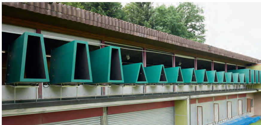
Fig. 23: Tunnel fonoassorbente (triangolare)
