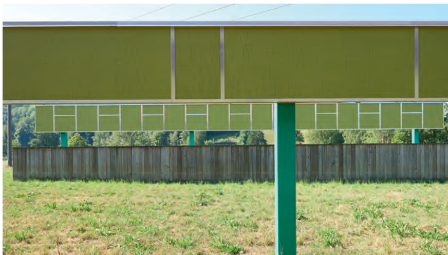
Fig. 62: Paratia di profondità in cemento armato e 2 paratie d'altezza di prossimità
