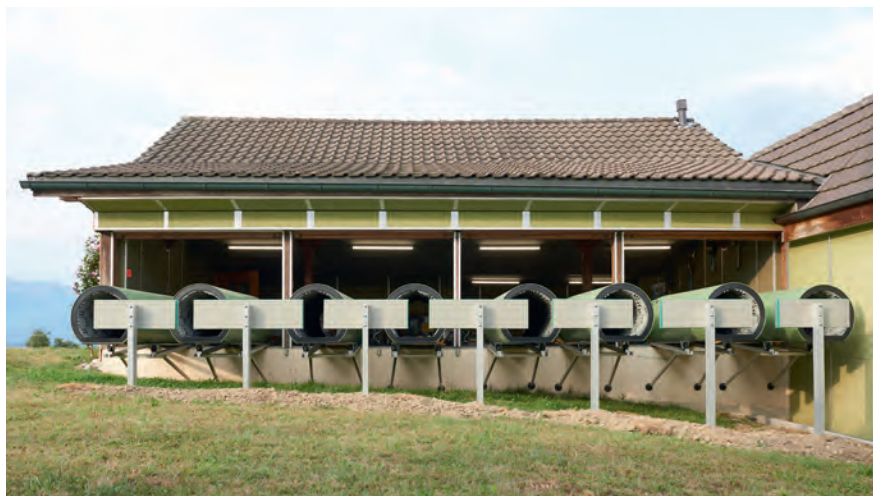
Fig. 64: Paratia laterale di prossimità per il tiro a terra con tunnel (vista dall'esterno)
