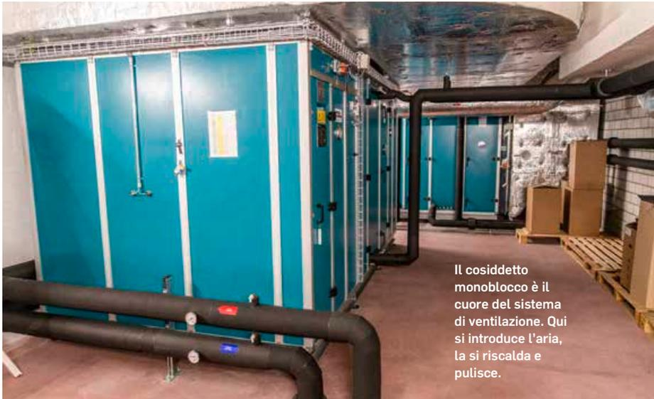
Il cosiddetto monoblocco è il cuore del sistema di ventilazione. Qui si introduce l'aria, la si riscalda e pulisce.
