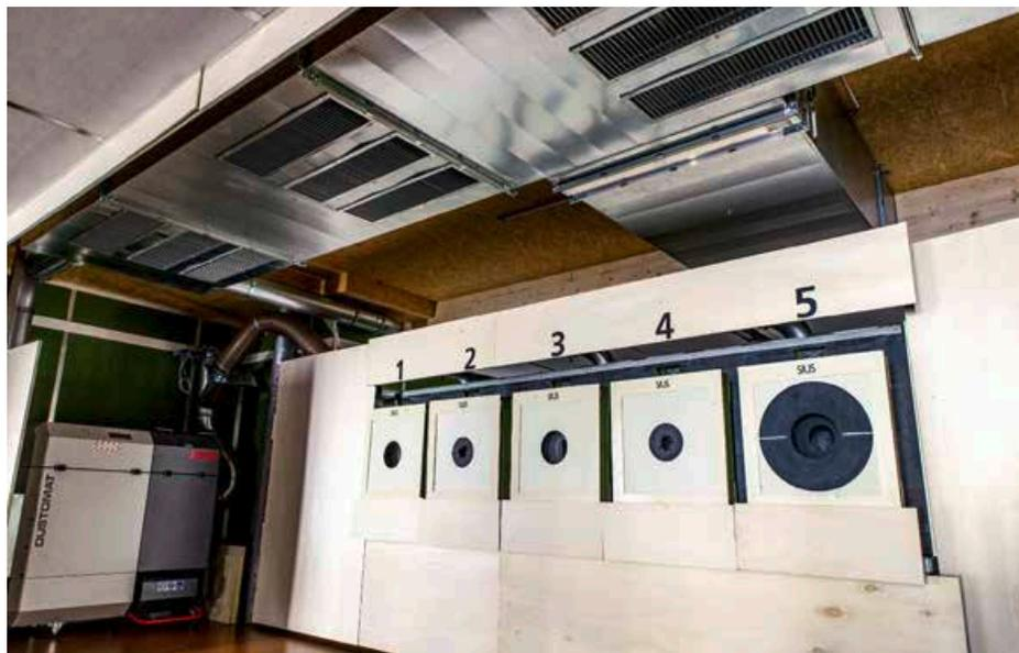
In ogni raccogli-piombo (qui dello dell'impianto 25m visto dal davanti e dal dietro) si aspira direttamente l'aria che viene condotta in un sistema che toglie la polvere.
