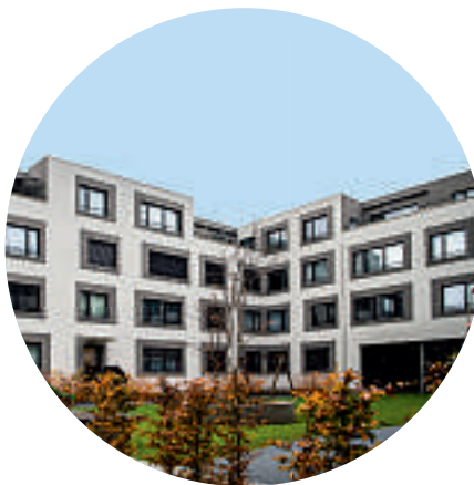
Les colocs de la division du Sport d'élite de la FST se situent dans un immeuble distant de quatre minutes à pied de l'installation de tir.
