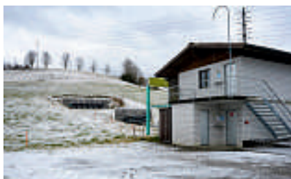
Installation de tir de Giffers
