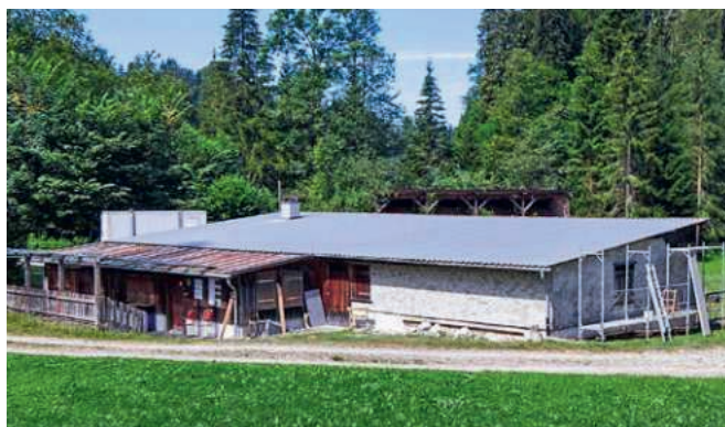
Le stand de tir avant le chantier du nouveau bâtiment.
