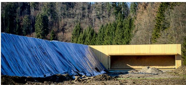
Die Zieleinrichtung der neuen dynamischen Schiessanlage mit Schnitzelbunker am oberen Rand des neu erstellten Schutzwalls.
