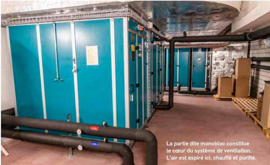
La partie dite monobloc constitue le cœur du système de ventilation. L'air est aspiré ici, chauffé et purifié.
