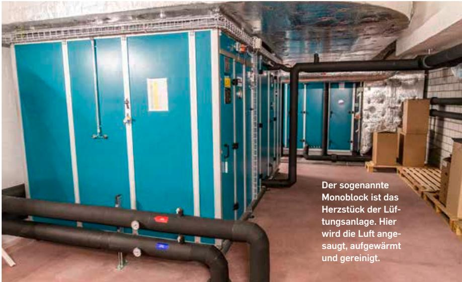
Der sogenannte Monoblock ist das Herzstück der Lüftungsanlage. Hier wird die Luft angesaugt, aufgewärmt und gereinigt.
