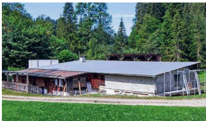
Die Anlage vor dem Ersatzbau.
